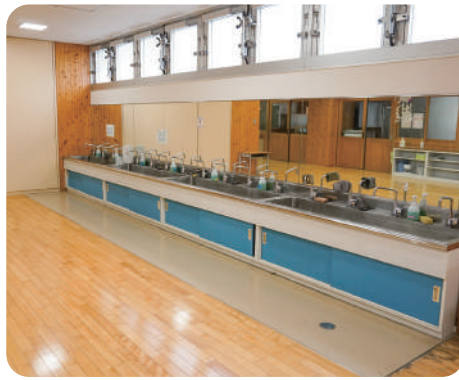
多目的スペースに設置された流し台
